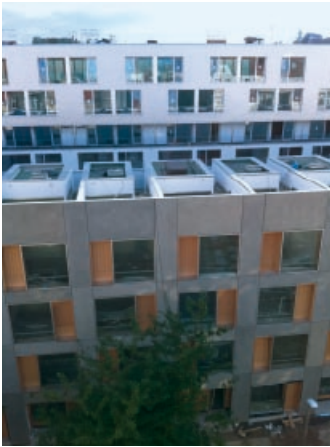
Abb. 9: ze511 Zelterstraße 5–11, Berlin Prenzlauer Berg, Straßenansicht Detail
