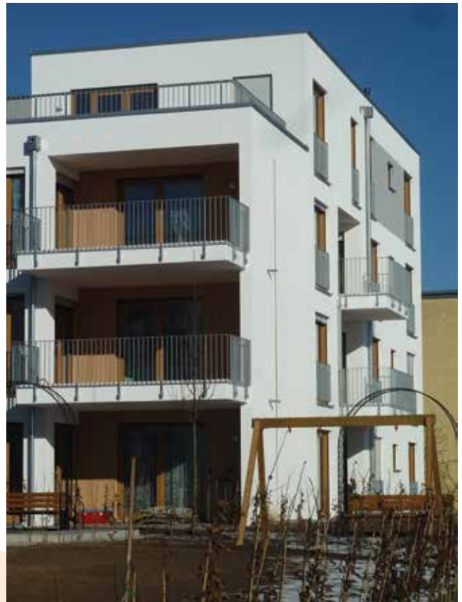
Wohnungsbau in Wiesbaden.
