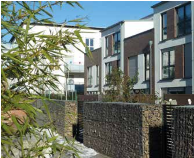
Wohnungsbau in Wiesbaden.
