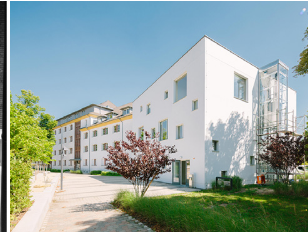
Ateliergebäude Evangelisches Gymnasium Neuruppin
