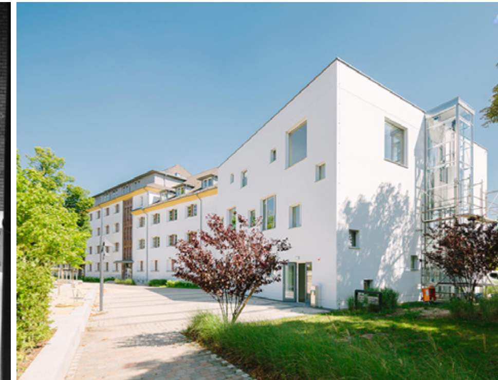
Ateliergebäude Evangelisches Gymnasium Neuruppin
