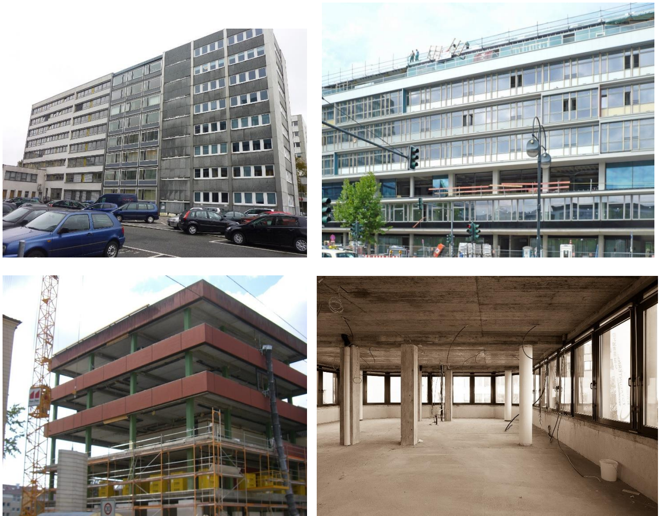
Abbildung 30: Typischer Skelettbau von Bürogebäuden
